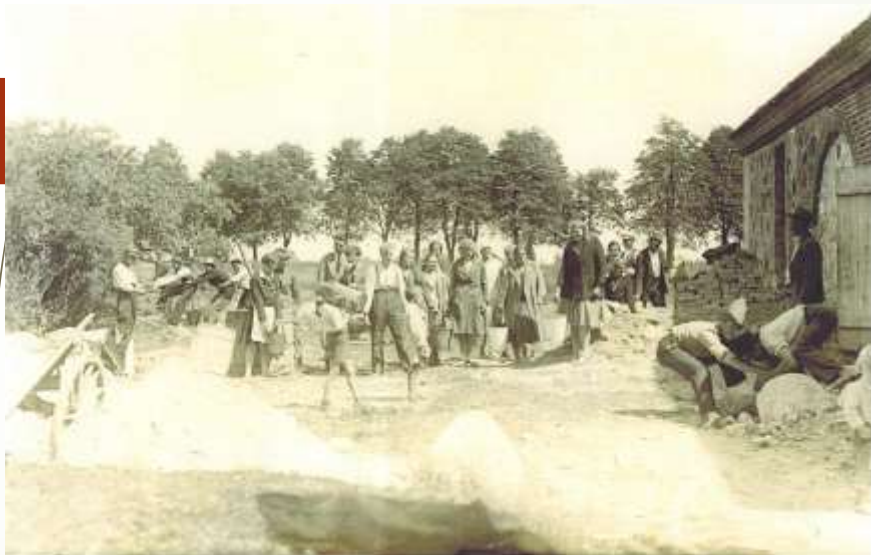
Kauguru bibliotēkas biedrības būves gaita 1932.gadā
