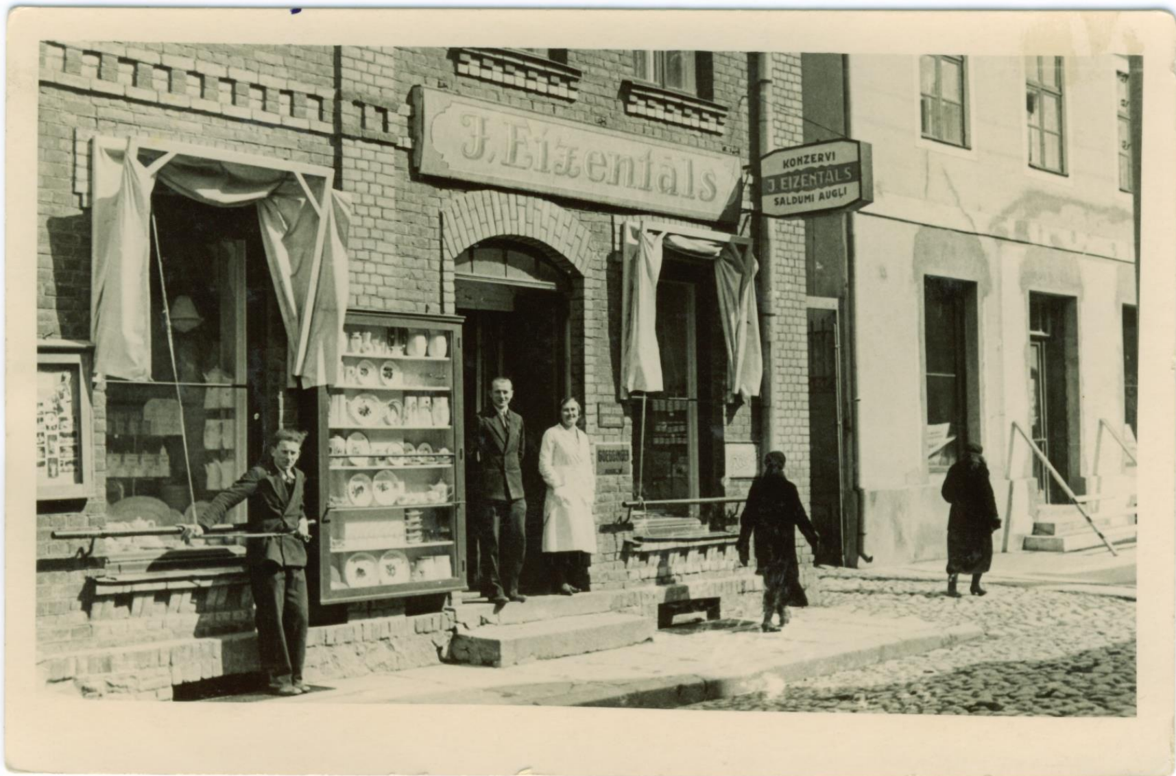
Veiksmīgs finansiālais ieguldījums Jānim Dūnim Rīgas ielas Nr.26. Savulaik lepnākais Valmieras nams. Šo 3 stāvu ēku 1901.g. no vācu tautības 2.gildes tirgotāja A. Šenroka nopērk latvietis, arī 2. ģildes tirgotājs Jānis Velēns. 1930.gadā īpašumu atpērk grāmatizdevējs Jānis Dūnis. Foto 1930. gadi. Redzams J. Eizentāla veikals.
