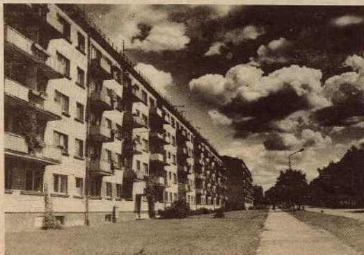
● Revolūcijas ielā — mūsu uzņēmuma celtās dzīvojamās mājas.
