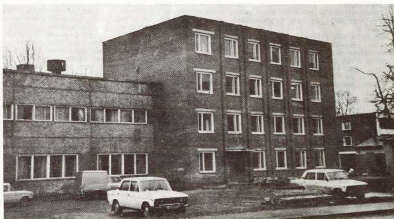
○ Siltumapgādes pārvaldes jaunais administratīvais un sadzīves korpusi, kas uzcelts rūpnīcas spēkiem un līdzekļiem. ALEKSEJA KOZINECA foto
