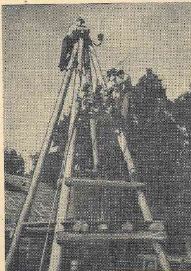
Attēlā: jaunie elektrīki praksē tehniskajā skolā № 4, ierīkojot jaunu elektrisko līniju.
