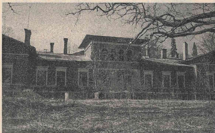
Jaunā kungu māja-pils. Austrumu fasāde. (2000. gads)
