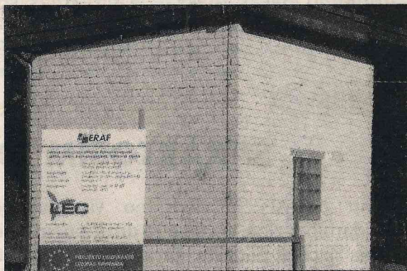
Līdzēnu rekonstruētā ūdenssūkņētava
